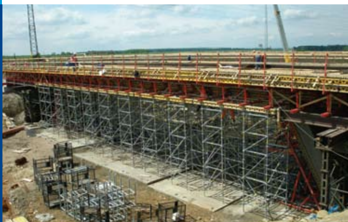
Výstavba mostu na silnici III/23739 v km 2,763
