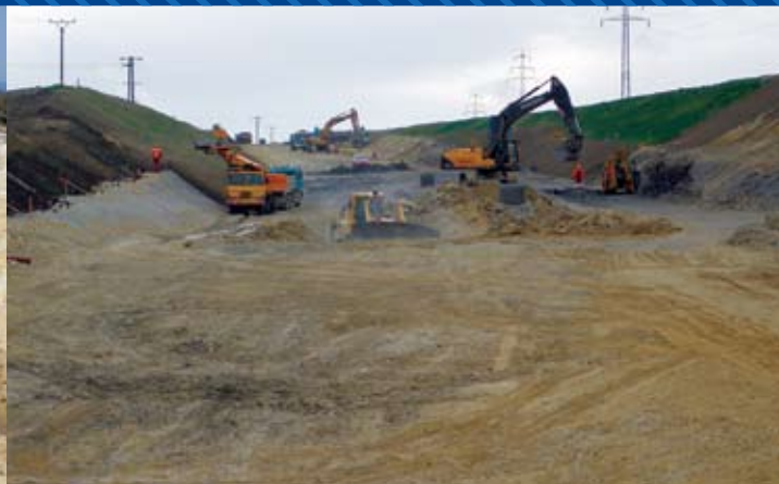
Postupující práce na těžbě zářezu
