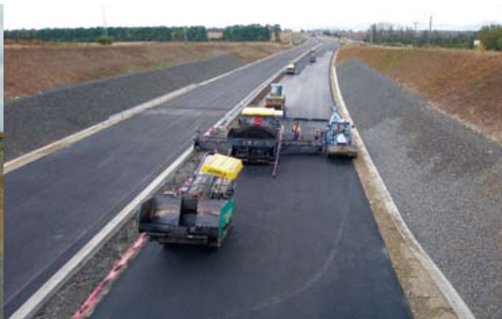
Pokládka obrusné vrstvy v km 2,700
