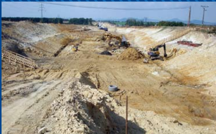
Těžba zářezu na hlavní trase
