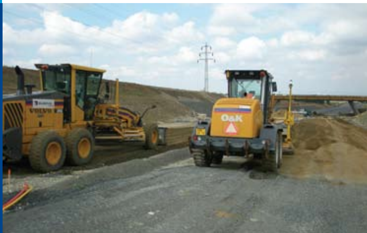
Úprava pláňe v km 2,500
