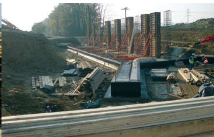
Výstavba mostu na R7 v km 2,042 přes biokoridor a silnici III/22934
