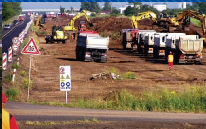
Nakládká a odvoz ornice včetně úpravy základové spáry, květen 2008
