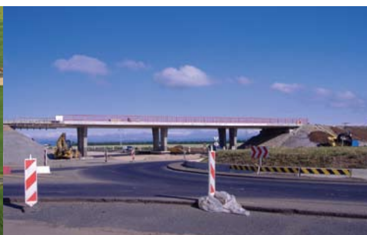
MÚK Vysočany – výstavba mostů a silnice R7
