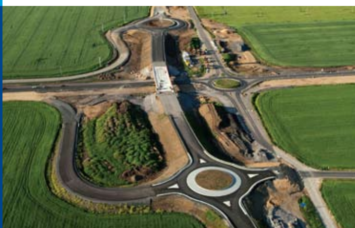
Výstavba mostů přes I/7 a samostatně R7
