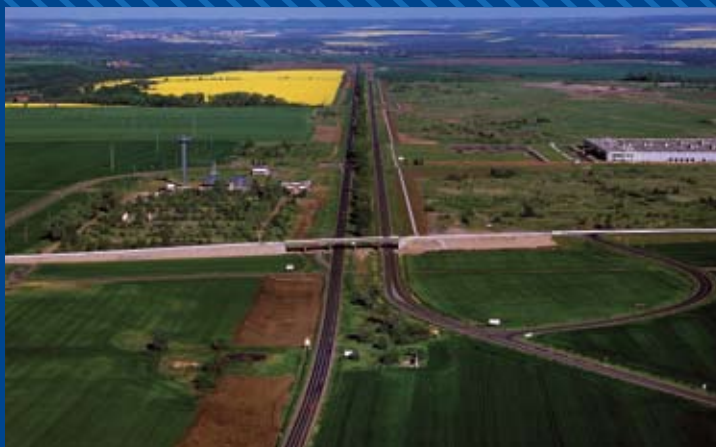
Začátek výstavby, skrytývka ornice v km 5,778–5,200, duben 2008
