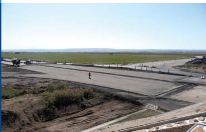
Rekonstrukce silnice I/7, uložení MZK v místě kruhového objezdu
