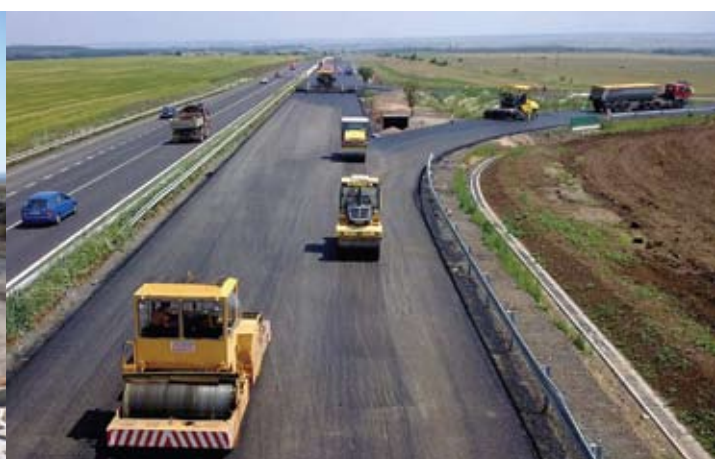
Pokládka obrusné vrstvy AKMS v km 0,000–0,900, srpen 2009
